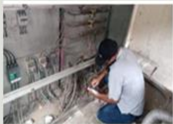
Mantenimiento electrobomba 1 1/2 hp, limpieza y ajuste de tapas
