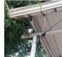
Suministro e instalación de reflector luz LED de 24W, con conexión a red eléctrica principal, con 6 metros de cable #8.
