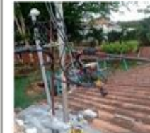
Suministro e instalación aérea de Cable antirraído monofásico 1x8-8 en área caseta de vigilancia, unidad sanitaria de preescolar, aulas de preescolar segundo piso y primaria primer segundo piso.
