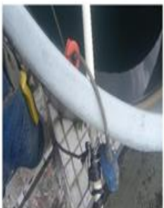
Suministro e instalación de flotadores eléctricos para tanque elevado de 5000 lt.
