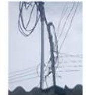
Suministro e instalación aérea de Cable antirraído monofásico 1x8-8 en área caseta de vigilancia, unidad sanitaria de preescolar, aulas de preescolar segundo piso y primaria primer segundo piso.
