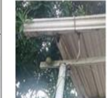
Suministro e instalación de reflector luz LED de 24W, con conexión a red eléctrica principal, con 6 metros de cable #8.
