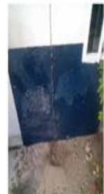
Suministro e instalación de varillas cooperthel de 3/8 x 1.20 cm con sus respectivos accesorios y andajes para reforzar el polo a tierra
